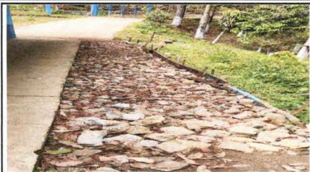
FOTO 1: Reparación de banqueta de concreto
