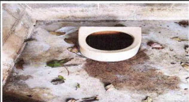
FOTO 13: Sustrucción de letrina por inodoro
