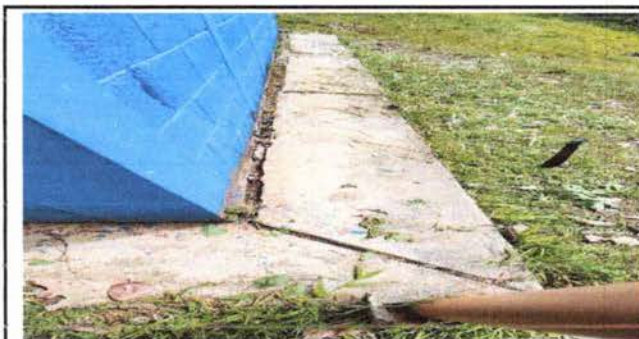
FOTO 6 : Reparación sustitución de piso de concreto
