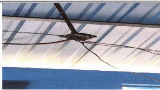
FOTO 2: Reparación de sistema eléctrico y cambio de lámparas
