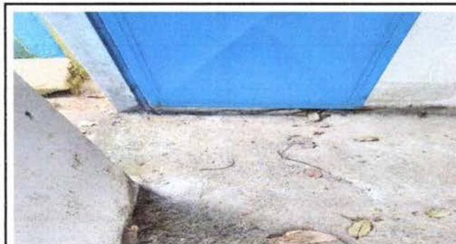
FOTO 7: Sustitución de piso ceramico
