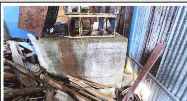
Foto: 8 aplicación de monocapa en pila de captación agua de lluvia
