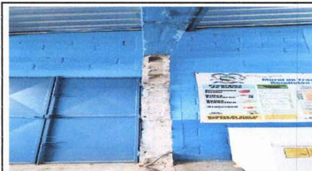
FOTO 3: Reparación de columnas
