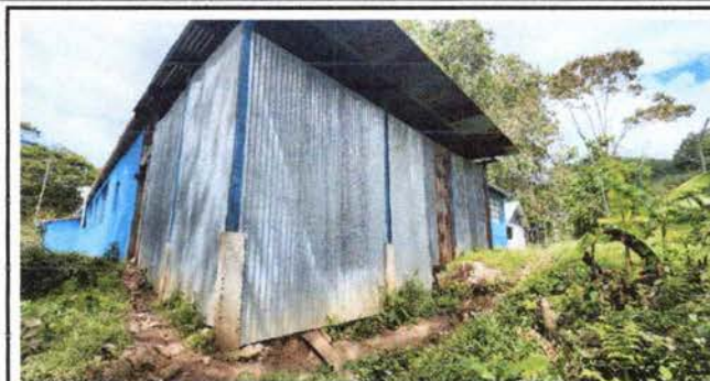
FOTO 7: Reparación de muro merlmetral y de columnas
