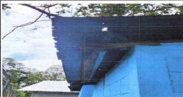
FOTO 15: Sustrucción canales y lamina troquelada
